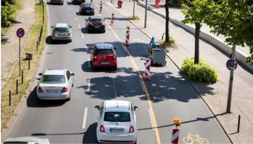
Eine Autospur weniger: So entsteht Raum für einen Pop-up-Radweg © imago images/David Weyand
