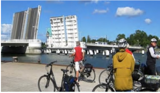
Brücke in Kappeln/Schlei
